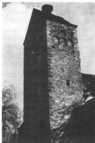
Torturm, der mittelalterlichen Friedhofsbefestigung bei der evang. Kirche. Unterbau etwa im 14. Jahrhundert entstanden, Backsteinoberbau aus dem späten 16.-17. Jahrhundert.
